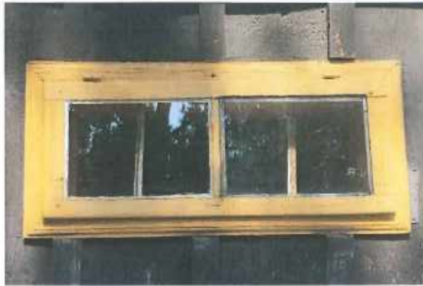
Rysunek 16. Widoczny brak okapników, prosta forma okna i niedokładność pasowania ramy okiennej.
