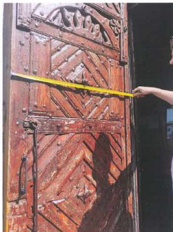
Rysunek 26. Widok skrzydła drzwi głównych od strony wewnętrznej. Widoczne ćwieki wzmacniające, unikalne opierzenie drzwi.
