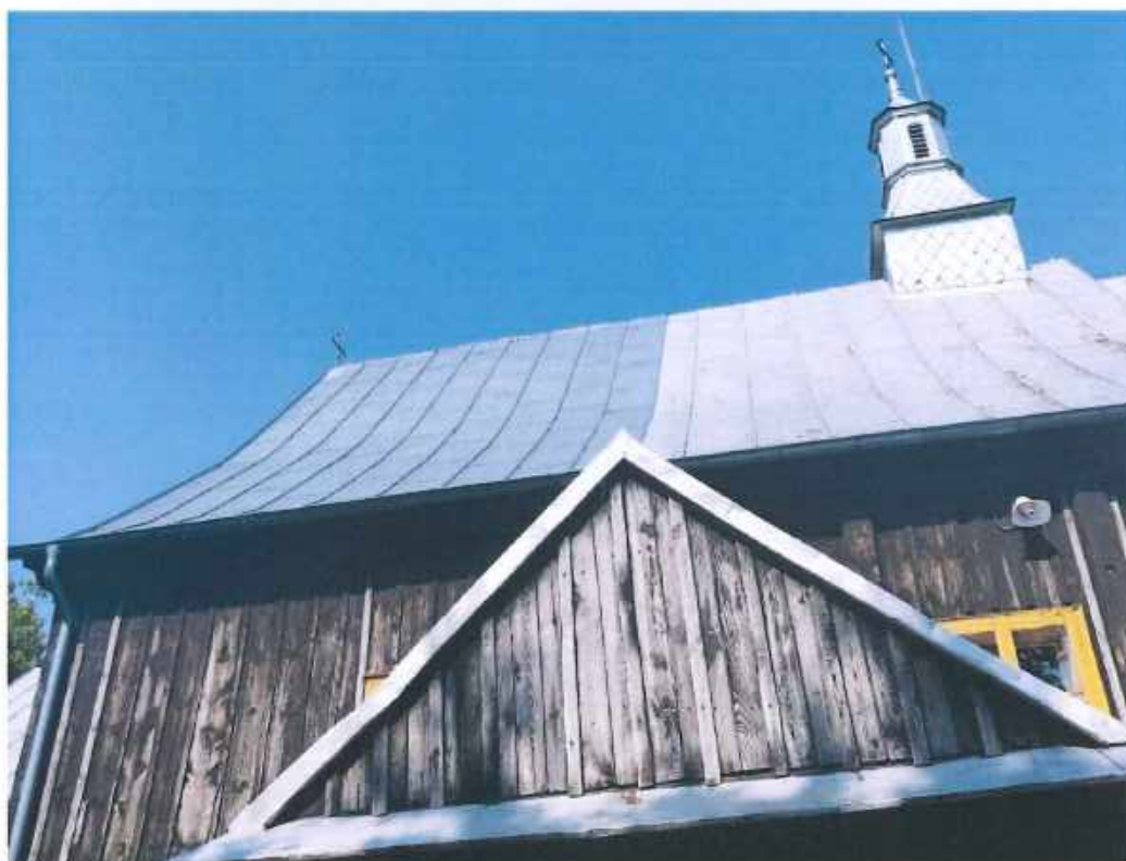
Fotografia 18. Widok połaci dachu od strony południowo-wschodniej. Widoczne bieżące naprawy połaci dachowej.
