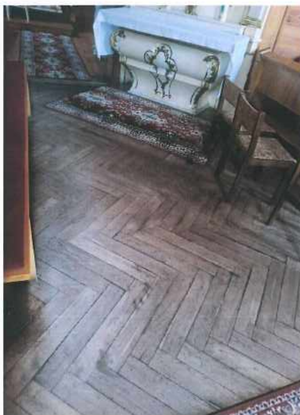
Fotografia 32. Podłoga w nawie głównej - widoczny parkiet (duża klepka, ułożony w jodełkę, lakierowany, element wtórny)
