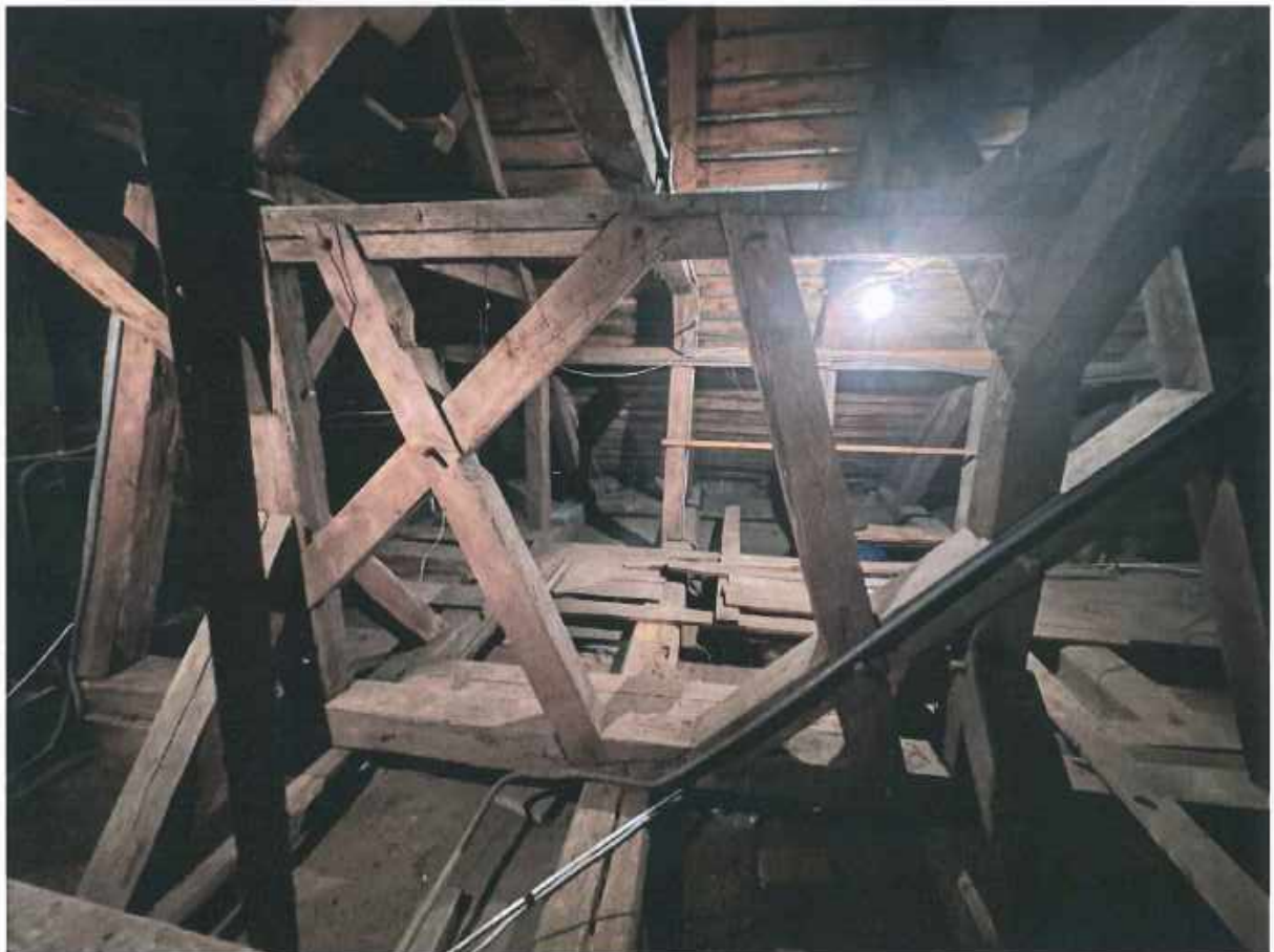
Fotografia 16. Konstrukcja dachowa nad korpusem kościoła – widok w kierunku zakrystii. Widoczne poprzeczne elementy konstrukcji storczykowej
