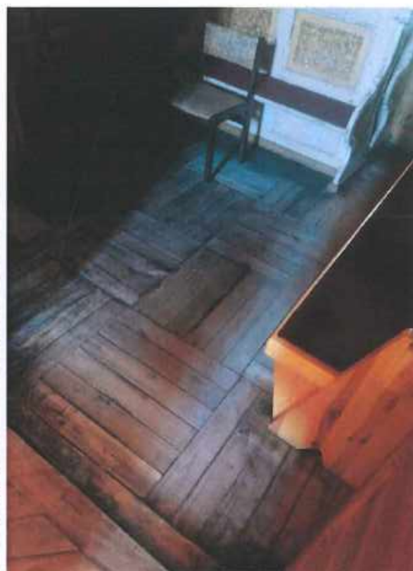
Fotografia 36. Podłoga w kruszcu bocznej – parkiet lakierowany ułożony metodą kombinowaną w szachownicę
