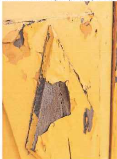
Rysunek 23. Widoczne 3 warstwy farb na skrzydle drzwi głównych od zewnątrz.
