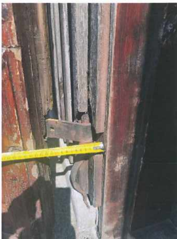
Rysunek 28. Widok skrzydła drzwi głównych od strony wewnętrznej. Widoczne kute zawiasy.
