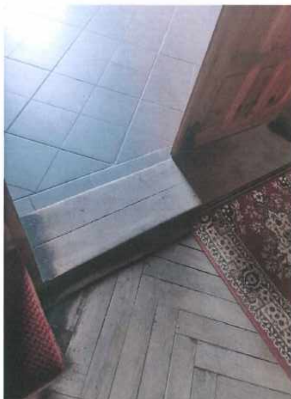
Fotografia 35. Podłoga w kruszcu i wejściu do nawy głównej – w kruszcu gres techniczny ułożony w karo na posadzce betonowej, w nawie głównej parkiet lakierowany.
