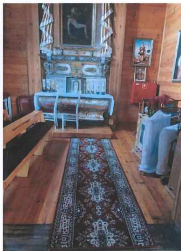
Fotografia 33. Podłoga w kaplicy bocznej - deska sosnowa lakierowana, z licznymi sękami, element wtórny
