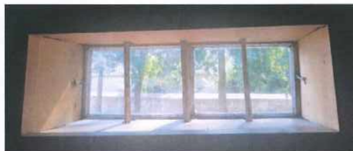
Rysunek 18. Widok okna od wewnątrz – z kruchty bocznej. Widoczne pionowe pręty (krata), haczyki, surowe wykończenie wewnętrzne.
