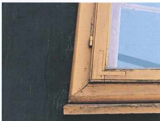
Rysunek 6. Widoczne okucia, zawiasy, ościeże i okapnik dolny. Rama okna szerokości ok 8 cm z zaokrąglonym zewnętrznym profilem.
