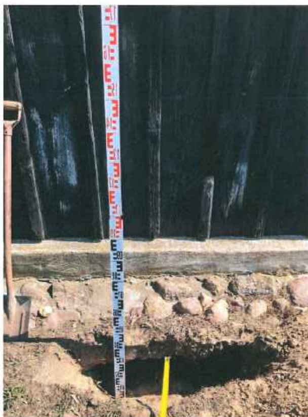
Fotografia 1. Odkrywka fundamentów nr 1 przy prezbiterium. Głębokość posadowienia i relikty starobruku kamiennego.
