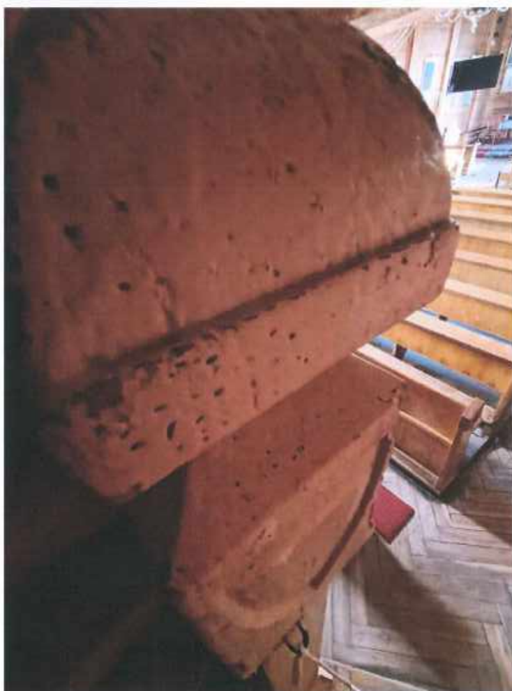
Fotografia 47. Schody na chór – widok na tralkę (ślady żerowania owadów)
