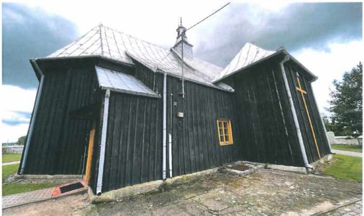
Fotografia 5. Widok elewacji północnej i wschodniej kościoła w Umieniu – kaplica boczna, zakrystia, prezbiterium
