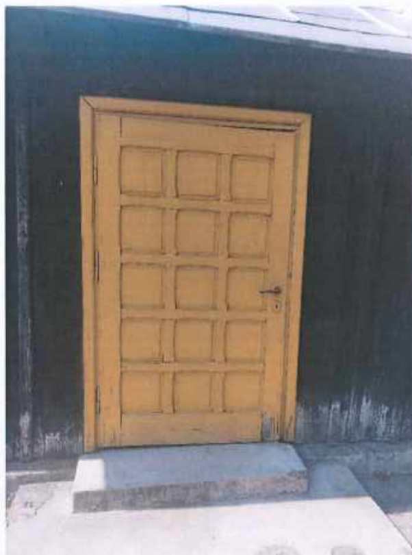
Fotografia 41. Schody wejściowe do kruchty bocznej – betonowe o nieregularnym kształcie
