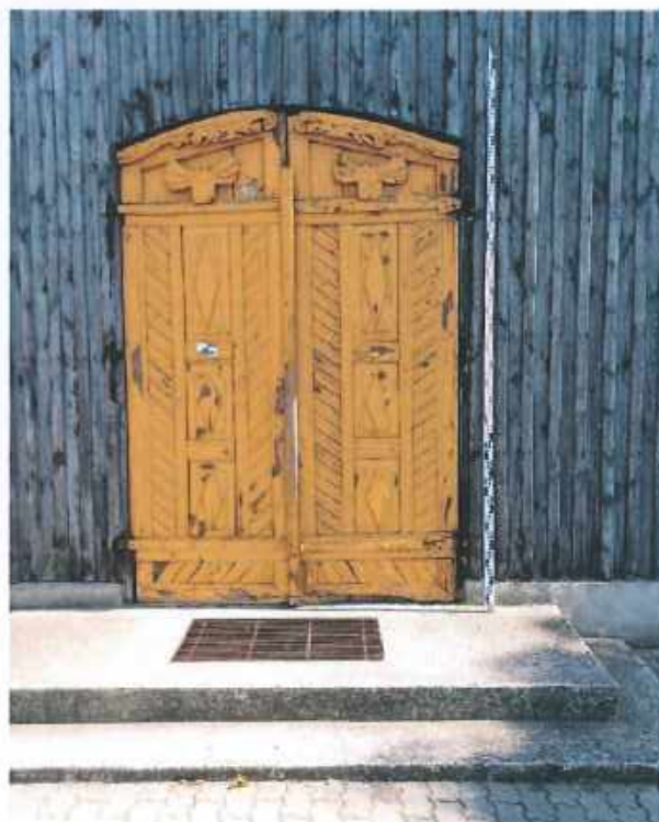
Fotografia 40. Schody przed wejściem głównym do kościoła – betonowe. Widoczna oblicówka ścian zewnętrznych kruchty o innym rozmieszczeniu desek niż starsza część kościoła.
