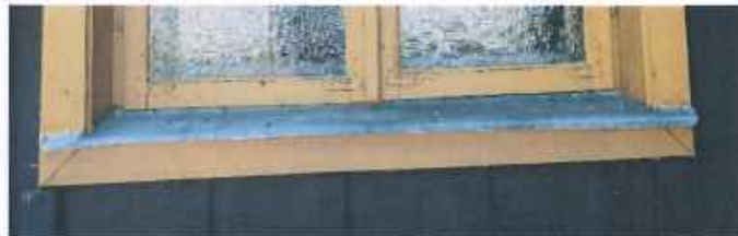
Rysunek 3. Parapet okna O1 – z blachy ocynkowanej, element wtórny.
