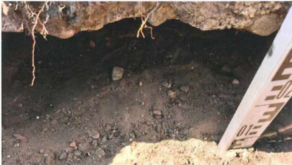
Fotografia 2. Odkrywka fundamentów nr 1 przy prezbiterium. Głębokość posadowienia, widoczne fragmenty rumoru kamiennego pochodzące ze ściany fundamentowej. Wykop w stanie suchym.
