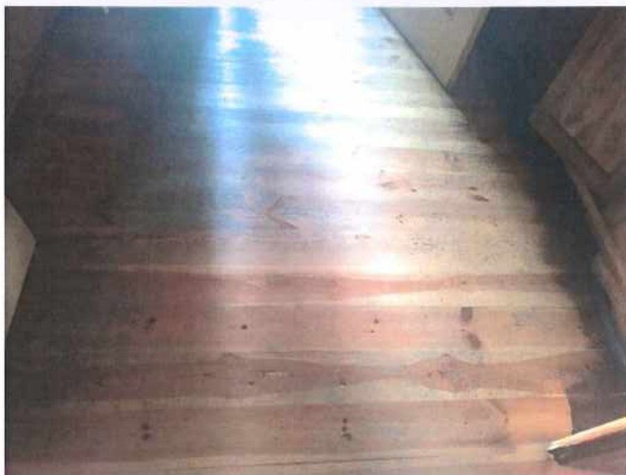
Fotografia 34. Podłoga w zakrystii - deska sosnowa lakierowana na wysoki połysk, z licznymi sękami, element wtórny.
