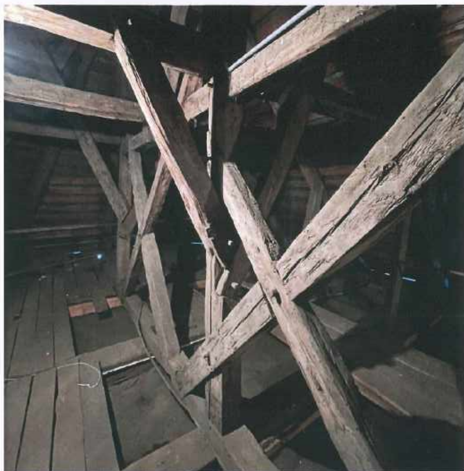
Fotografia 13. Konstrukcja dachowa nad prezbiterium
