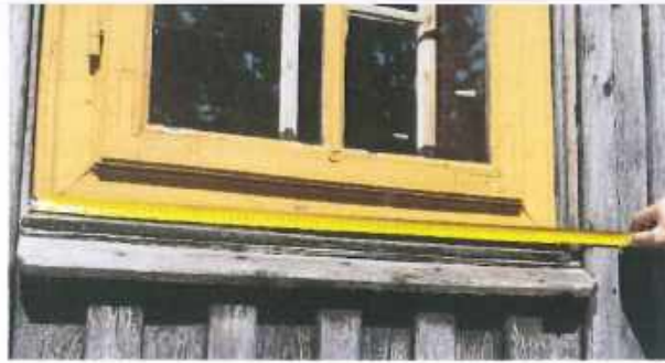
Rysunek 11. Widoczny okapnik dolny (parapet).
