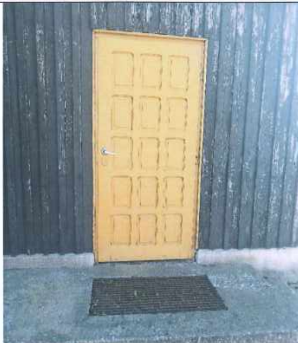
Rysunek 29. Widok ogólny z zewnątrz na drzwi boczne do kruchty głównej
