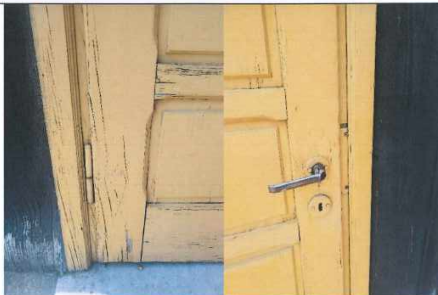
Rysunek 34. Widoczne ościeża i zawiasy a także klamka aluminiowa i szyld zamka.
