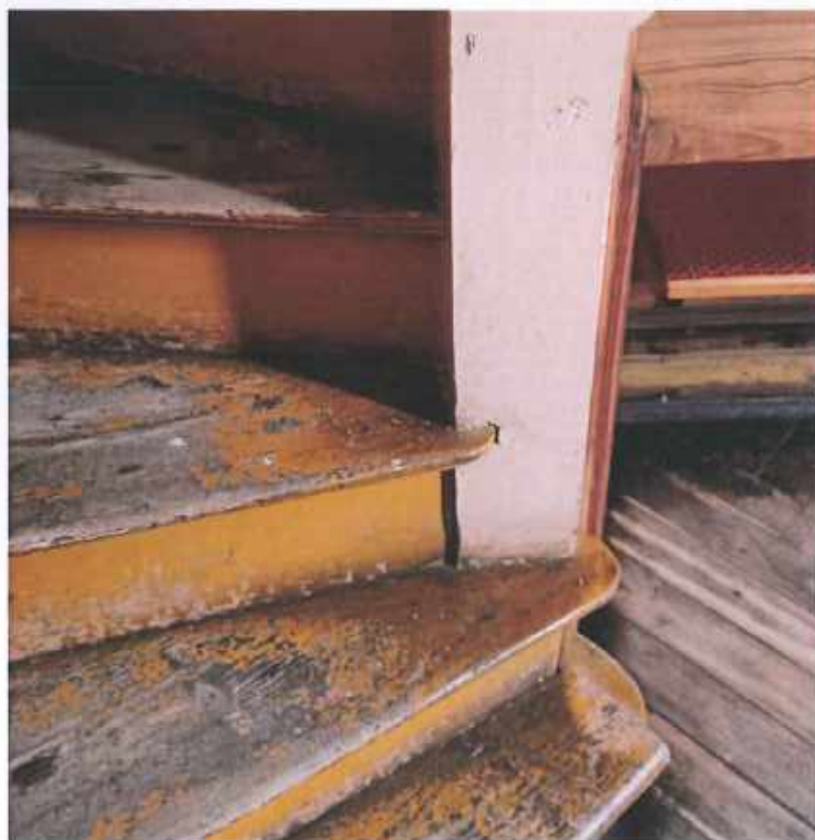
Fotografia 45. Schody na chór – widok na zabieg schodowy
