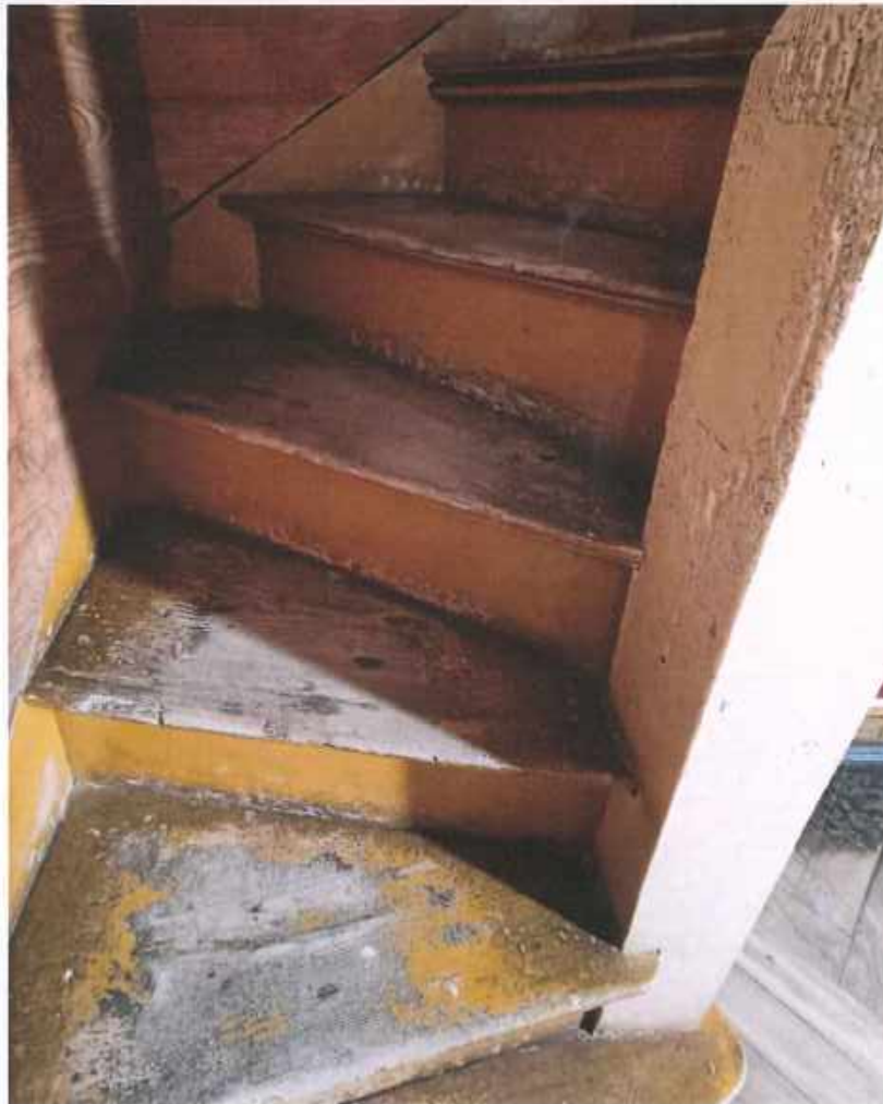
Fotografia 10. Schody na chór – widok na wytarte, wyżłobione stopnie i zniszczony przez owady słupek poręczy
