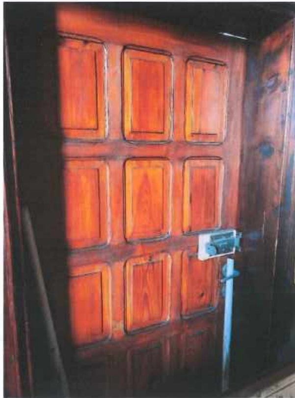
Rysunek 32. Widok od wewnątrz na drzwi boczne do kruchty
