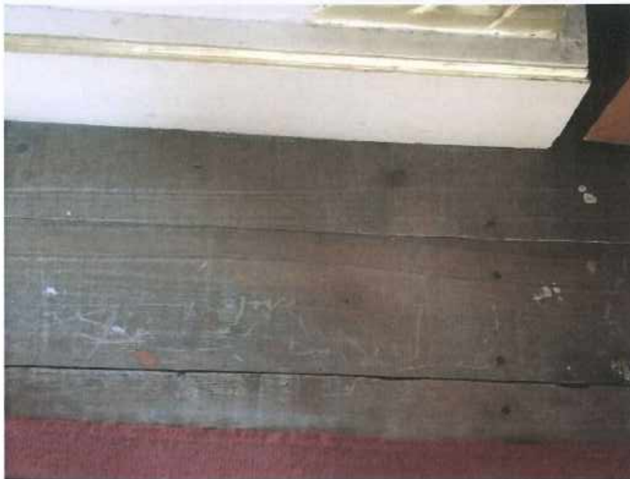
Fotografia 37. Podłoga w prezbiterium – podest drewniany przed ołtarzem głównym. Deska dębowa nielakierowana.
