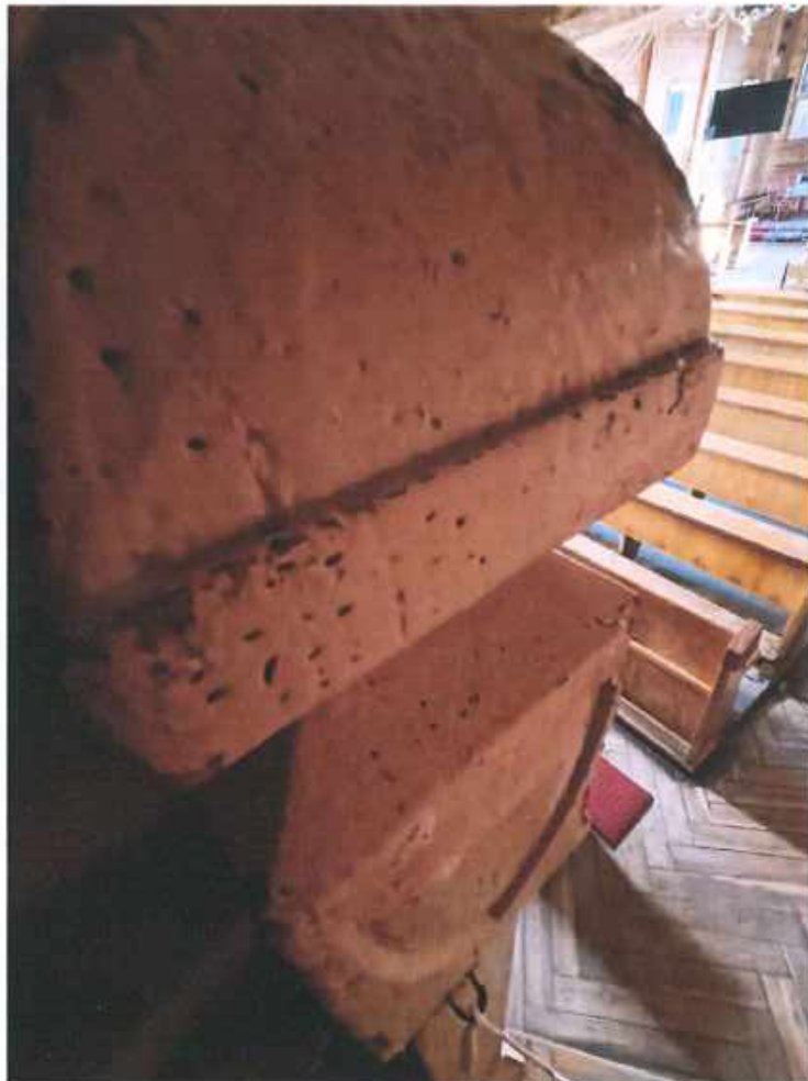
Fotografia 9. Schody na chór – widok na tralkę (ślady żerowania owadów)
