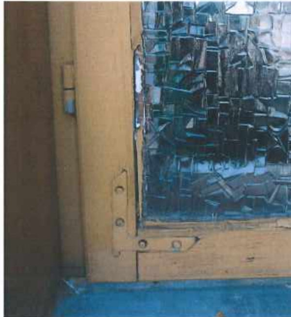
Rysunek 2. Wzmocnienie ramy i zawias. Szyba osadzona na kit.
