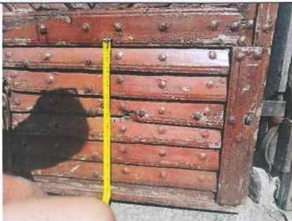
Rysunek 27. Widok skrzydła drzwi głównych od strony wewnętrznej. Widoczne ćwieki wzmacniające, unikalne opierzenie drzwi.
