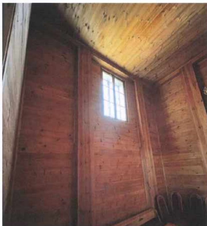
Fotografia 28. Kaplica boczna - ściany i sufit pokryte boazerią sosnową o dużym usękowieniu, lakierowaną na połysk
