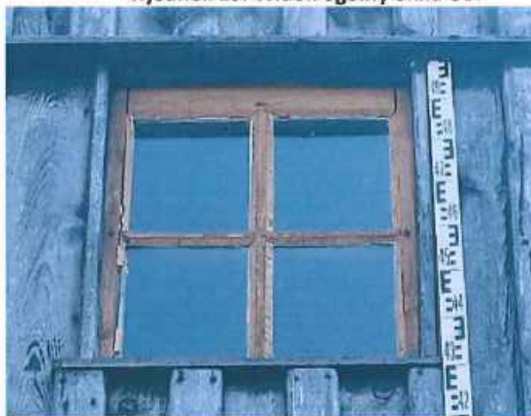
Rysunek 20. Widoczny podokiennik dolny, pogrubiona górna belka ramy okiennej.
