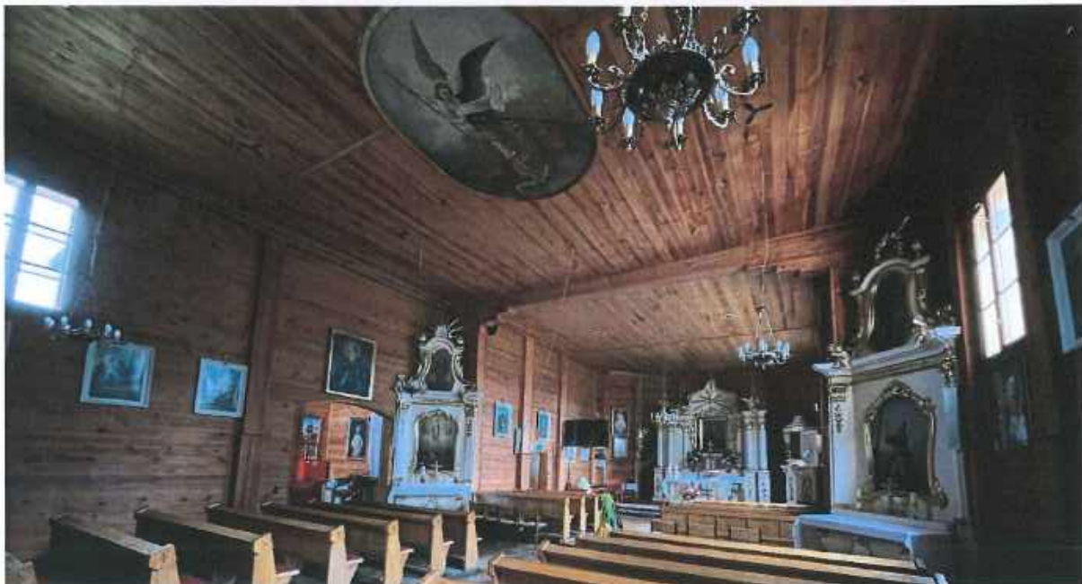
Fotografia 27. Sufit i ściany w nawie głównej w kierunku prezbiterium pokryte boazerią sosnową lakierowaną. Widoczna belka pomiędzy prezbiterium a nawą główną.
