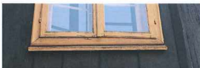
Rysunek 7. Widoczny okapnik dolny okna O2.
