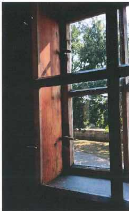
Rysunek 14. Widok okna O3 od wewnątrz – z kruszty kościoła. Widoczne klamki, wykończenie wewnętrzne okna surowe.
